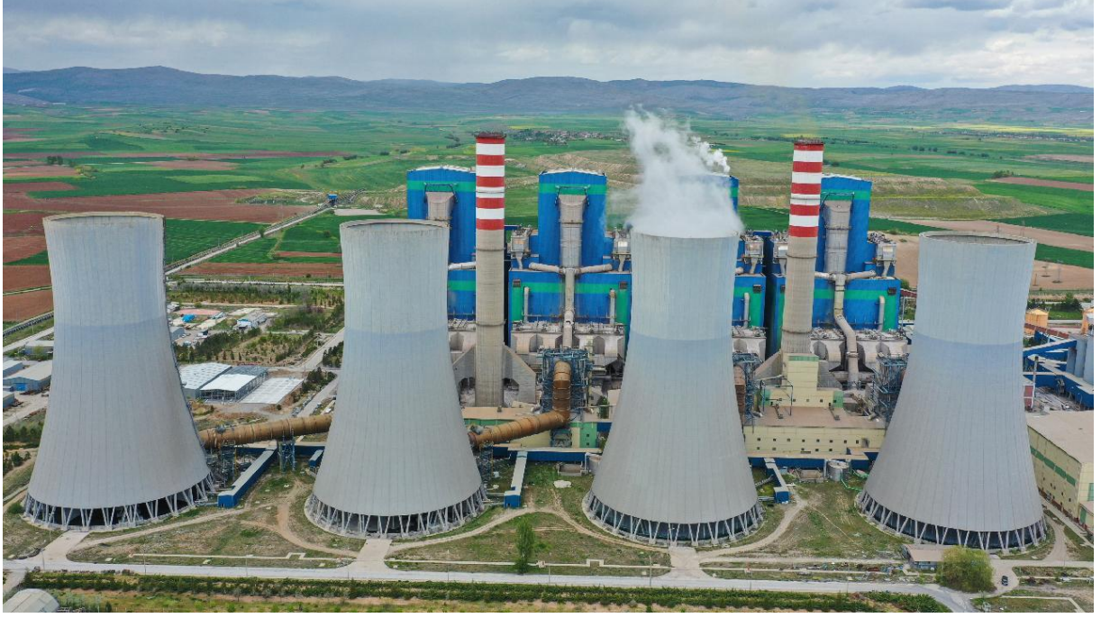
Afşin-Elbistan B Termik Santrali
