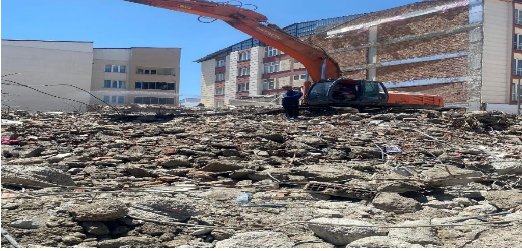
Yıkım ve Hafriyat Kaldırma Çalışmaları
