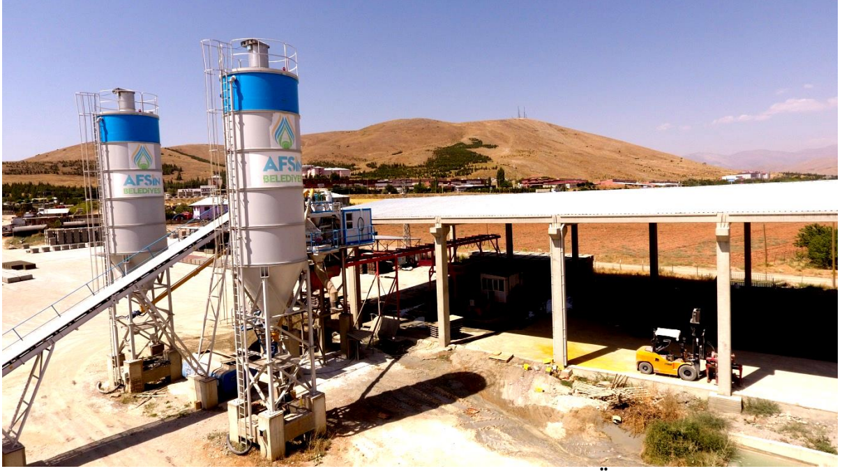
-Afşin'e Kazandırdığımız Beton Elemanları Üretim Tesisi-
