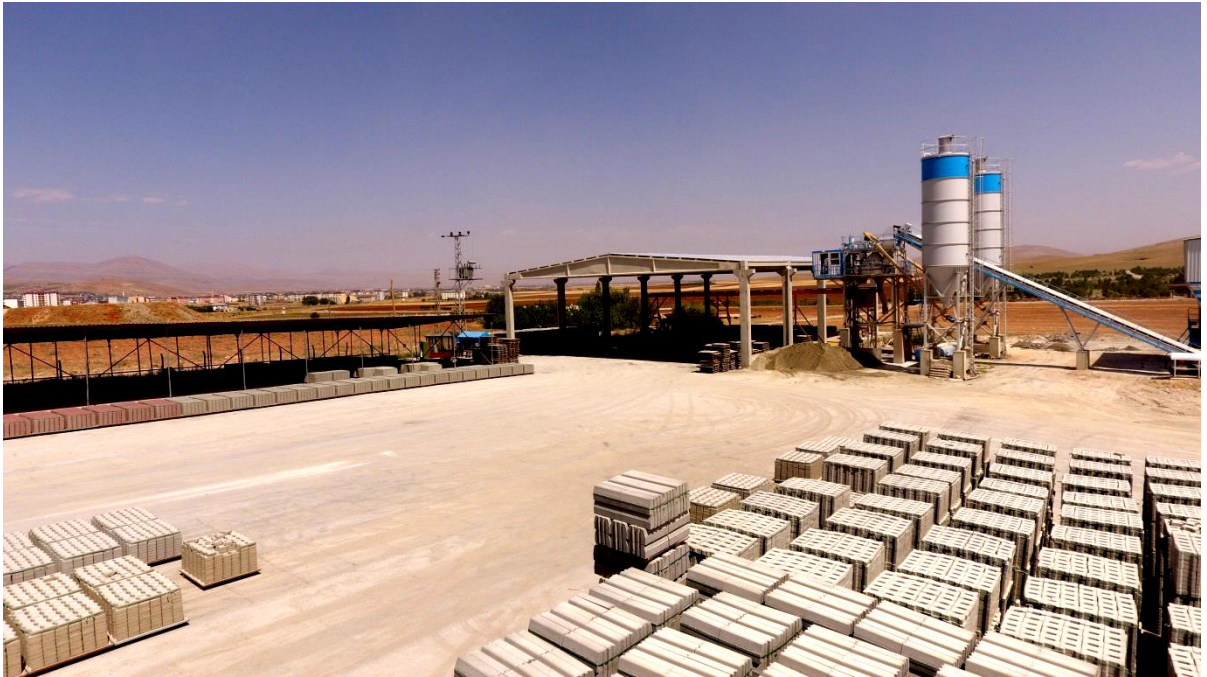
-Afşin'e Kazandırdığımız Beton Elemanları Üretim Tesisi-
